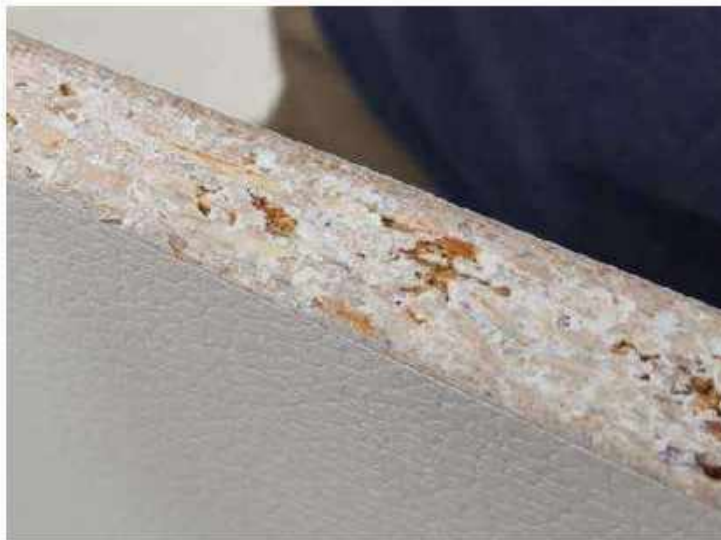
Figura 71. Esempio di strato funzionale delaminato
